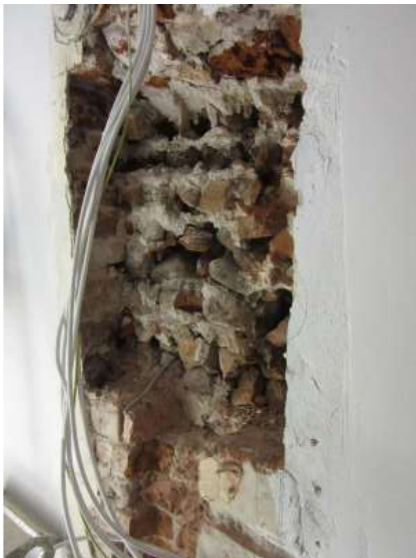
Foto 16 Väliseina „sisu“. Kividevaheline seotis on väga minimaalne
